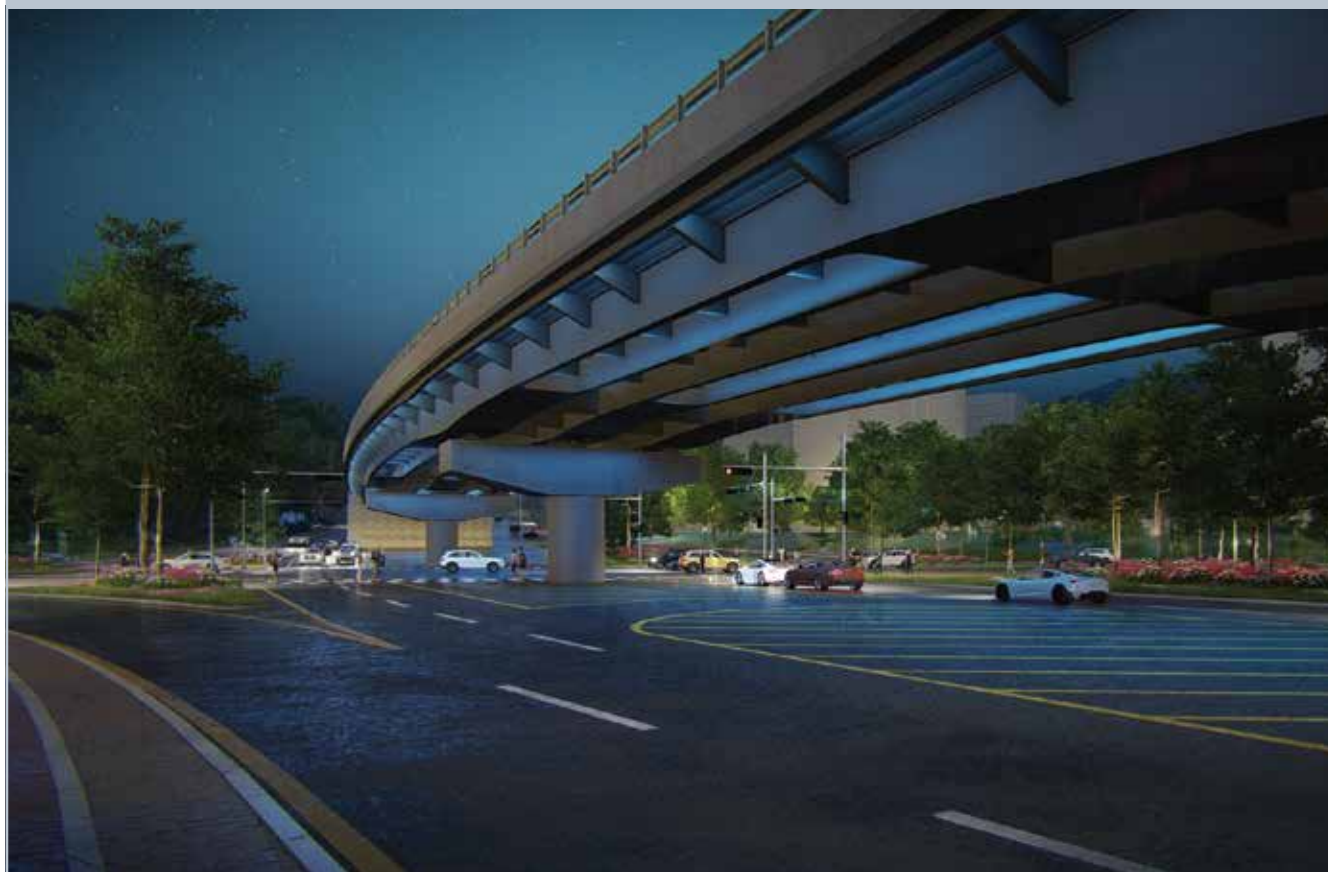
청주율량2 상리고가차도 건설공사
