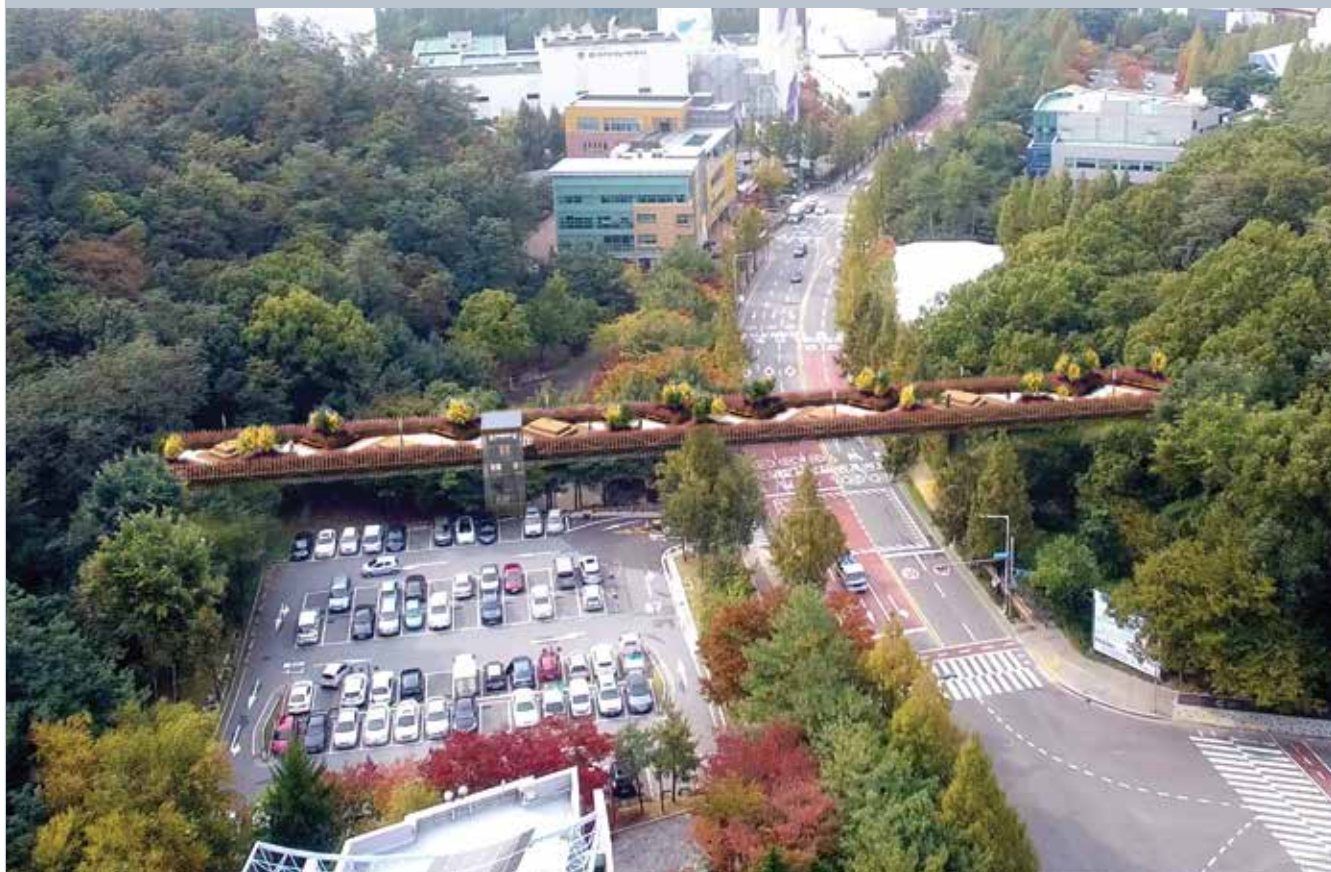
영흥공원~영통 중앙공원 녹지연결로 설치공사
