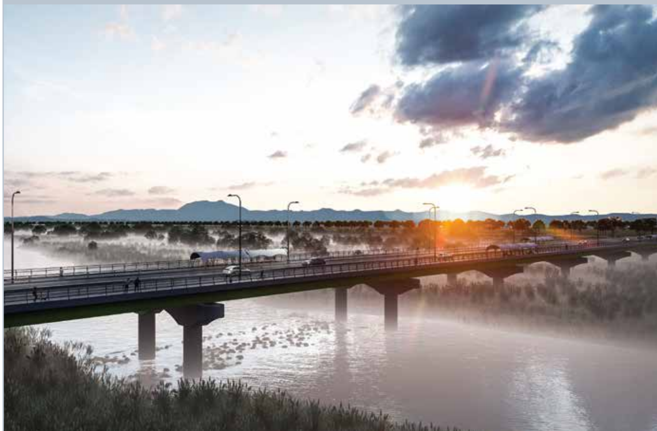
황룡강 송정지구 하천환경정비사업-장록교
