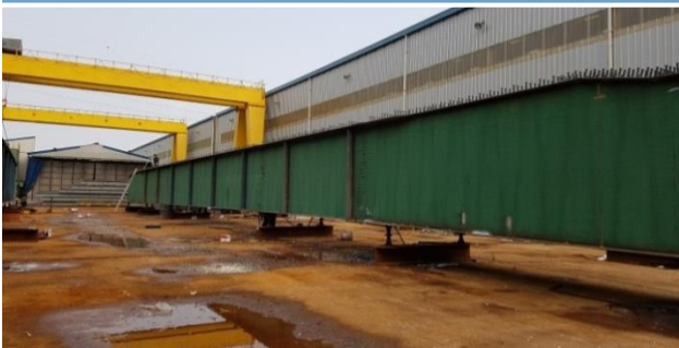
STEP 4 : 공장 가조립
