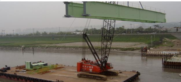
STEP 7 : 지조립 및 거더 설치
