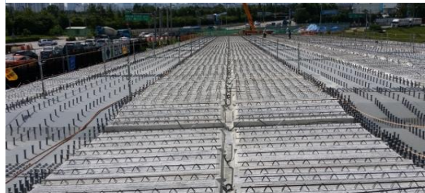
STEP 8 : 콘크리트 충전 및 바닥판 슬래브 타설
