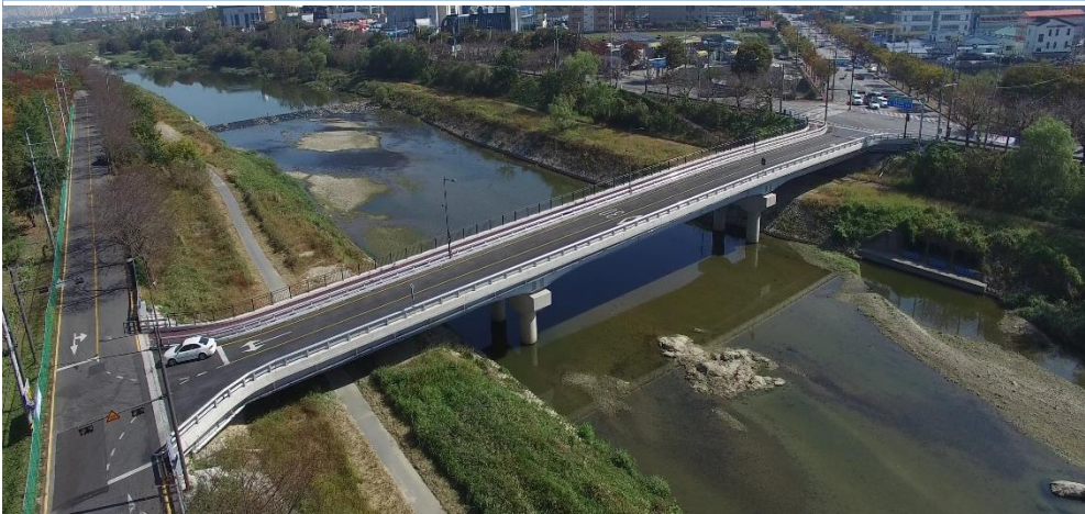
상무지구-하수처리장 진입도로(교량) 개설공사
