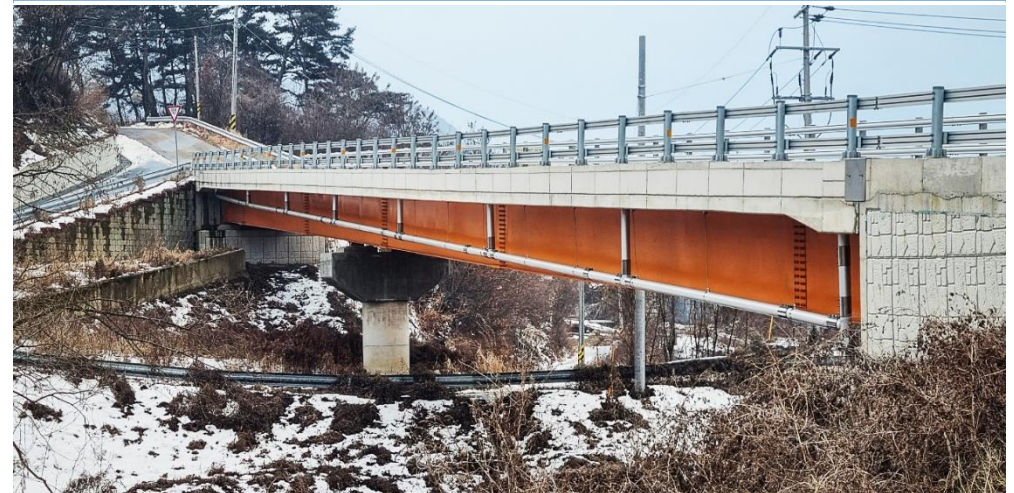
남원 인월 장평마을 진입로 정비공사
