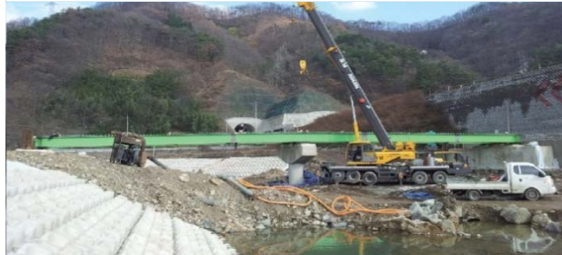
STEP 8 : 현장가설 및 콘크리트 충전, 슬래브 타설
