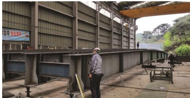
STEP 5 : 공장 가조립
