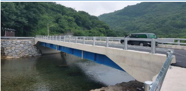
STEP 8 : 거푸집 설치 및 준공
