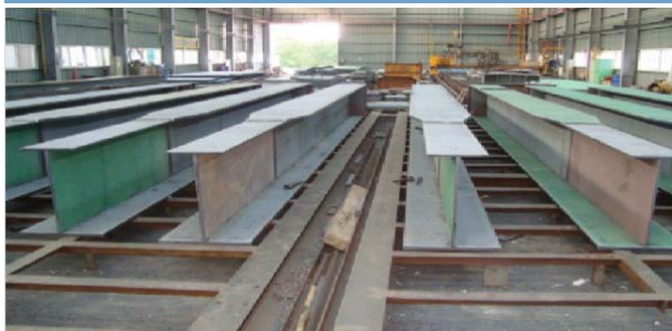
STEP 2 : 거더 조립 및 용접
