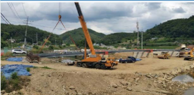
STEP 5 : 거더 설치
