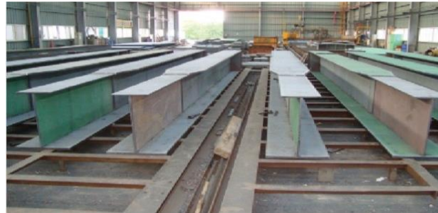
STEP 2 : 거더 조립 및 용접
