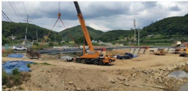
STEP 5 : 거더 설치
