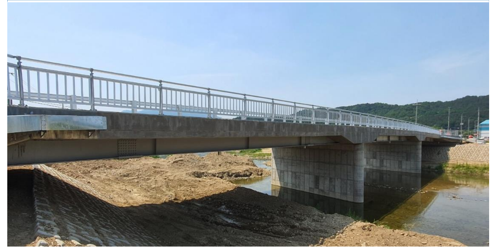
자연재해위험 개선지구 정비공사(교리)
