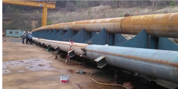
STEP 5 : Main Pipe Girder 가조립
